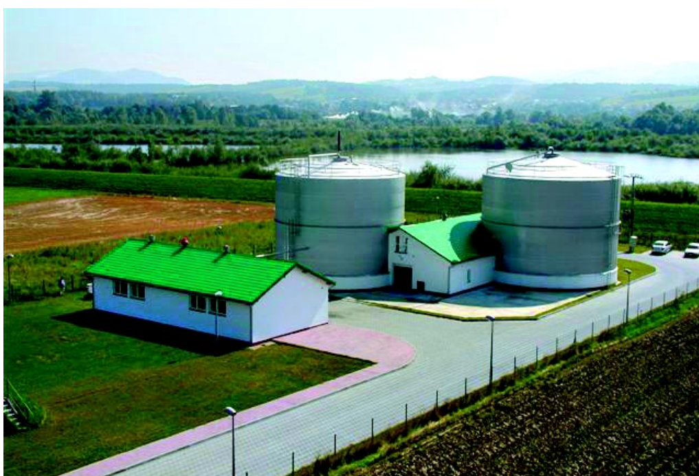
Oczyszczalnia ścieków w Podrzeczu
