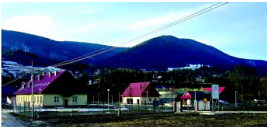
Oczyszczalnia ścieków w Mszanie Dolnej
