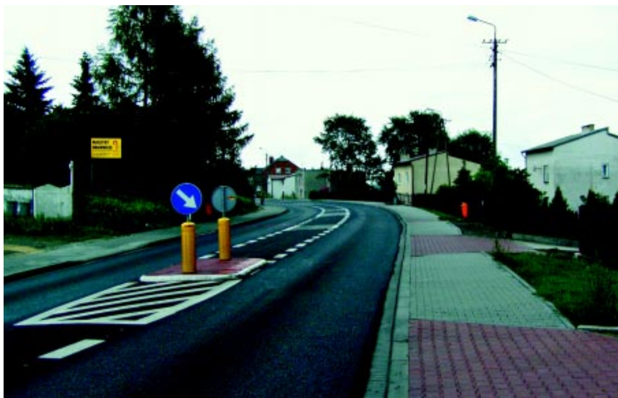
Modernizacja drogi wojewódzkiej nr 780 w Chełmku
