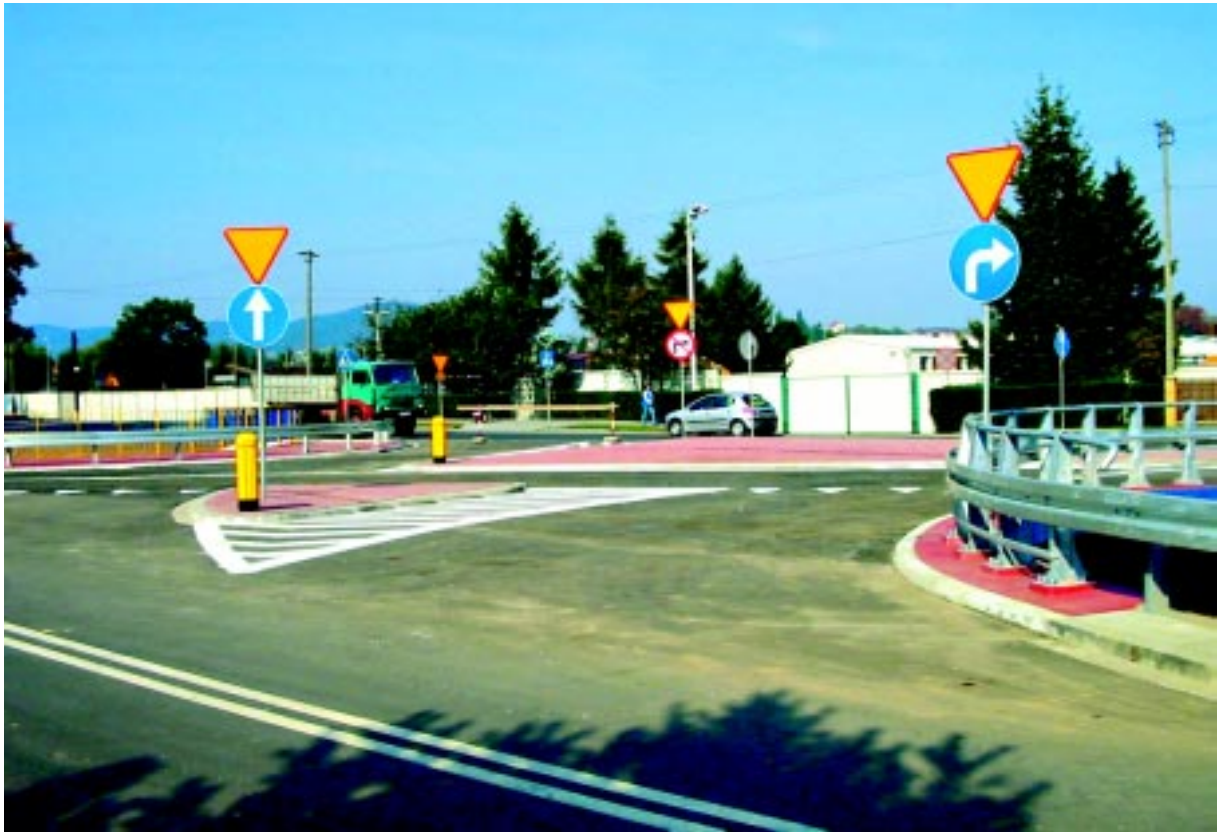
Przebudowa drogi dojazdowej do mostu na potoku Bysinka w Myślenicach
