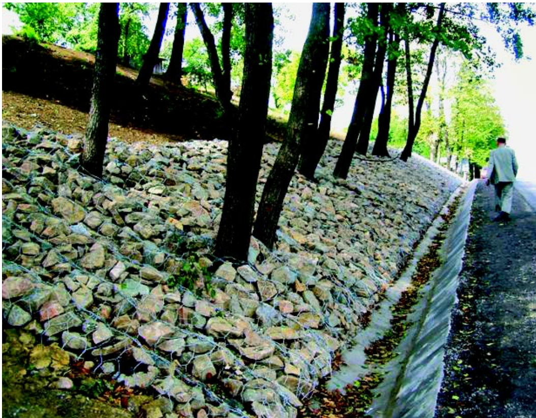
Zabezpieczenie osuwiska, odbudowa korpusu drogowego, nawierzchni i urządzeń odwadniających na drodze wojewódzkiej nr 965 w m. Kopaliny, gm. Nowy Wiśnicz
